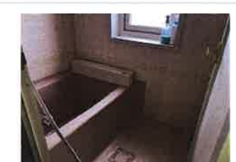
2階浴室・ユニットバス
