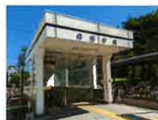
地下鉄東豊線 月寒中央駅
